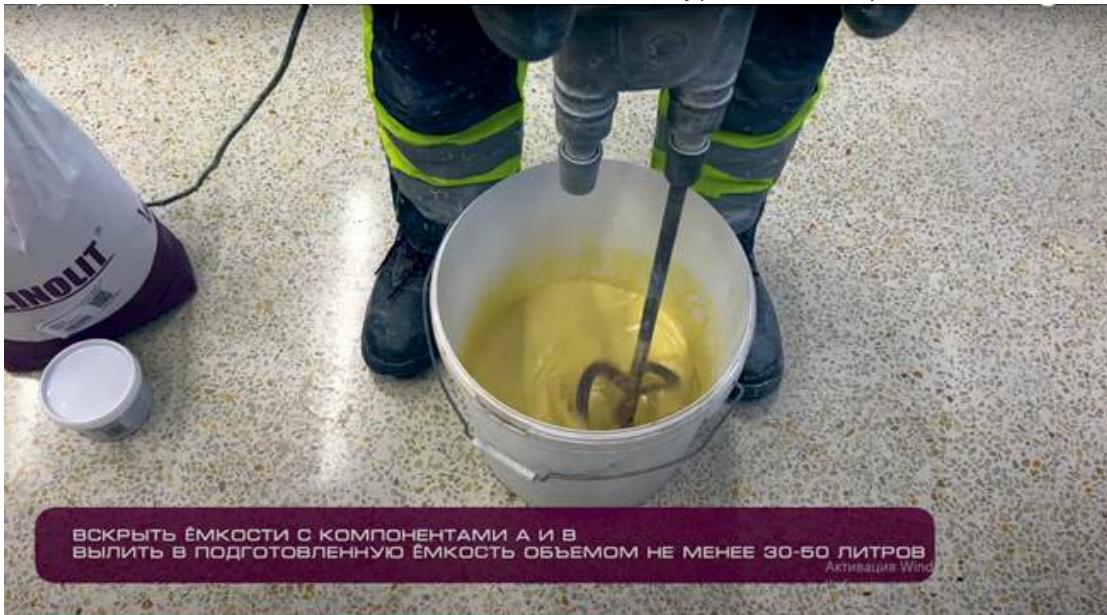
2. Постепенно внести наполнитель (компонент С) в смесь, мешать в течение минимум 3 минут до полного перемешивания и получения гомогенной (однородной) смеси. Рекомендуемое время смещивания 2-3 минуты. Особое внимание следует уделять тщательному перемешиванию материала в зоне дна и стенок ведра во избежании дефектов покрытия (плохо перемешанные компоненты и комки сухой смеси не полностью вступают в химическую реакцию).
